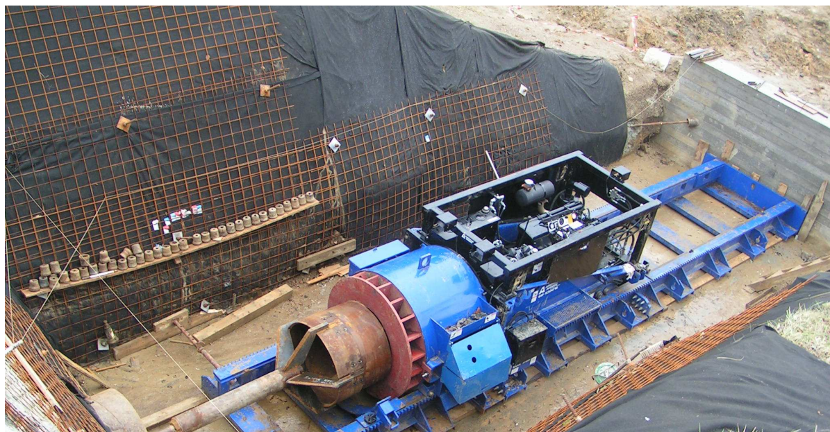
Rézsűs oldalhatárolású indítóakna (jelen esetben szegezett részsűkkel)
