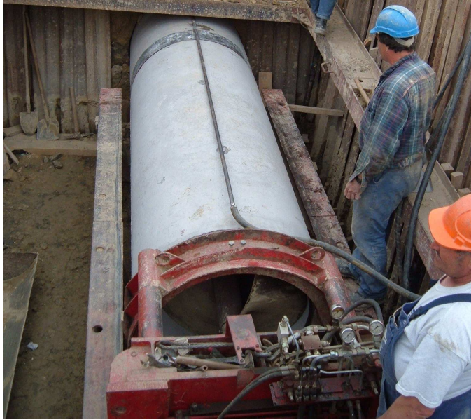
Witte BPR80-as gép NA1000 mm-es vb. cső sajtolása közben
