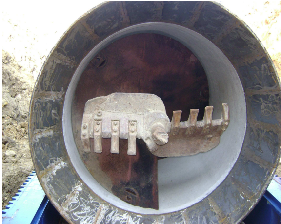
A vágóél kialakítása vb. cső sajtolása esetén, a csőben lévő fúrófejjel és fúróspirállal.
