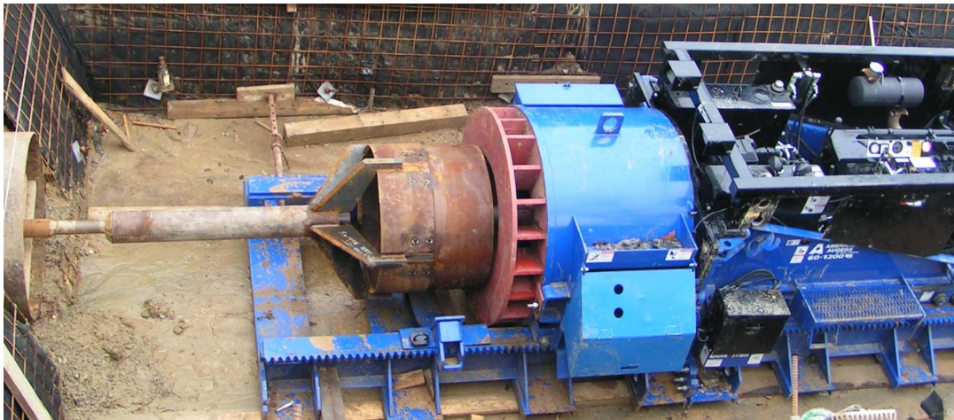
NA1000 mm-es acélcsőre szerelt pilótarudas vágóél
