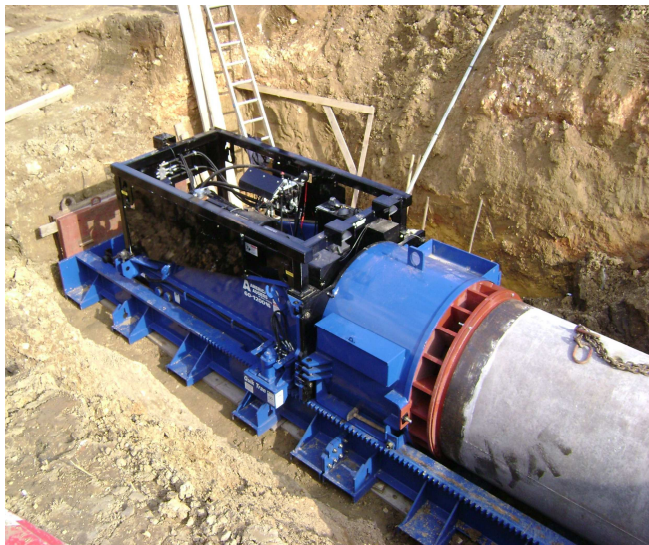
Az American Augers 60/1200 NG típusú fúró/sajtoló gépe
