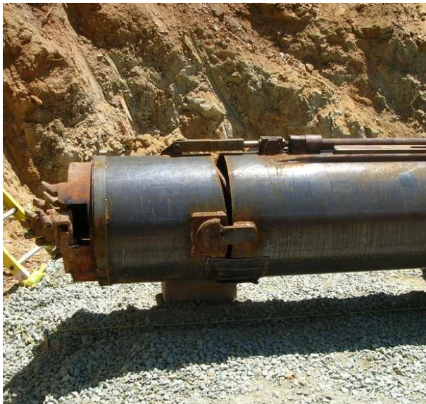
Fúrás/sajtolásra előkészített acélcső csuklós kialakítású vágóéllel és száraz, közepesen kemény talajra kialakított fúrófejjel (Horizontal Holes Inc.)
