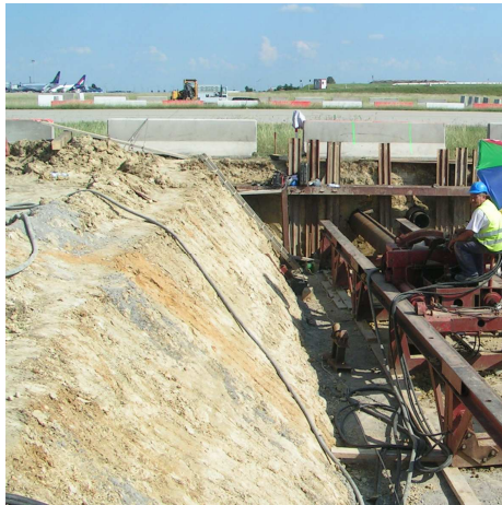
46 m és 86 m hosszú NA400-as pilótarudas irányított fúrás/sajtolás Ferihegy II. gurulóútja alatt
