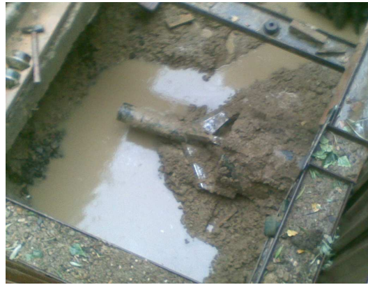
NA600-as acélcső pilótafuratos irányítással történő fúrás/sajtolása 96 m hosszban a Kelenföldi pu. alatt
