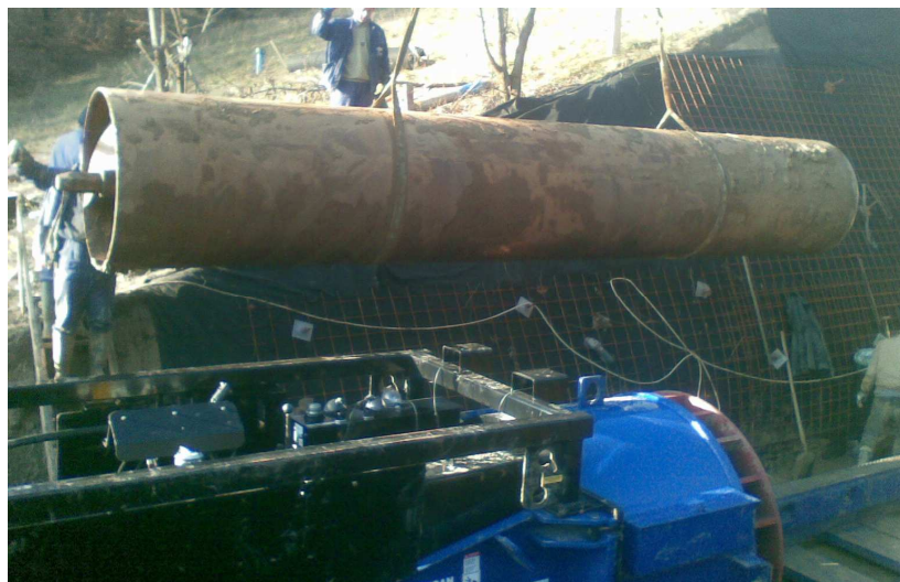
NA1000 mm-es acélcső pilótafuratos irányított fúrás/sajtolása 87 m hosszban, Gyöngyösorosziban
