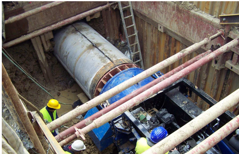
NA1200 mm-es vb. cső fúrás/sajtolása a Budaörsi út / Brassó u. keresztezésében
