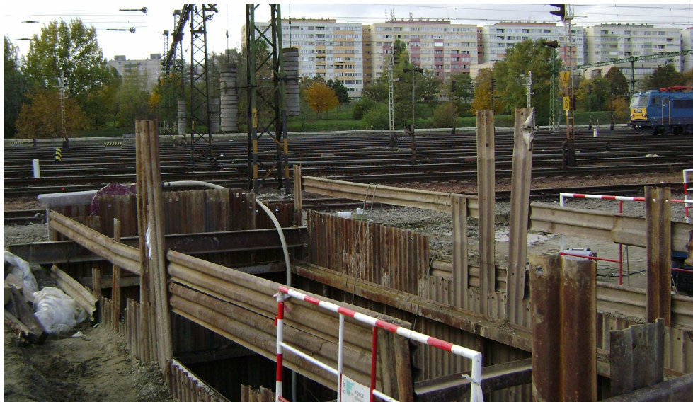
A sínpárok látványa a 96 m hosszú sajtolás indítóaknájától
