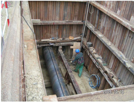
NA600-as acélcső pilótafuratos irányítással történő fúrás/sajtolása 96 m hosszban a Kelenföldi pu. alatt
