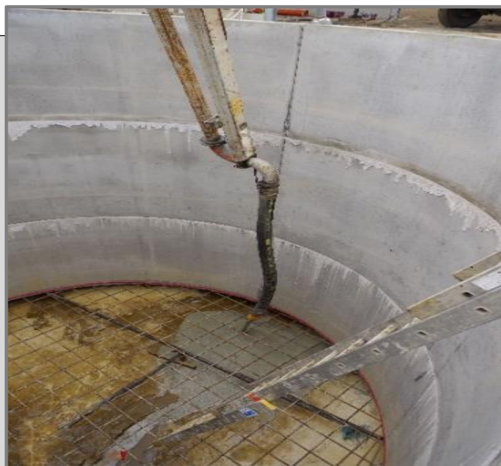
80 m3-es szeparátor akna betonozása
