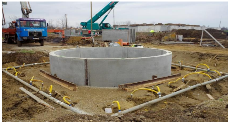
Vákuumos talajvíz süllyesztést alkalmaztunk
