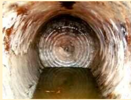
Jól látható „talajkontrasztok” a sajtolási szelvényben
