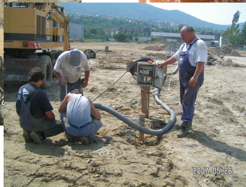
Vízszintszabályozó rendszer beüzemelése
