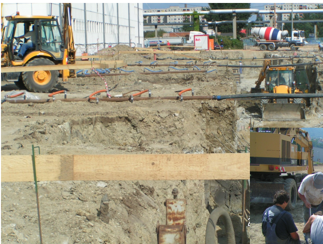
Folyamatos víztelenítés melletti munkavégzés
